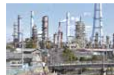
■ 化学プラント監視
