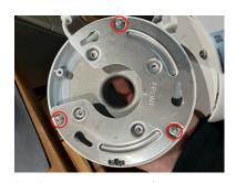
③ ②で外したネジで IPP-101PL に プレート金具に三点止めします。※ネジーつ使いません。取り付けた時に FRONT が正しい位置に来るように気を付けます。
