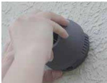
④ ブラケットのマグネット部に本体を取り付け、角度調整します。
