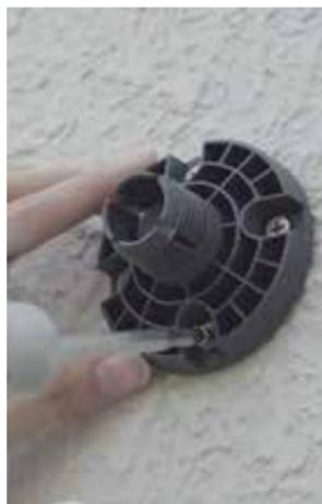
③ ブラケット台座カバーの取付をします。回して取り付けます。
